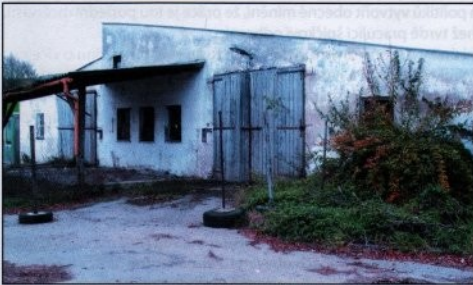
Bývalý kravín JZD Želechovice
